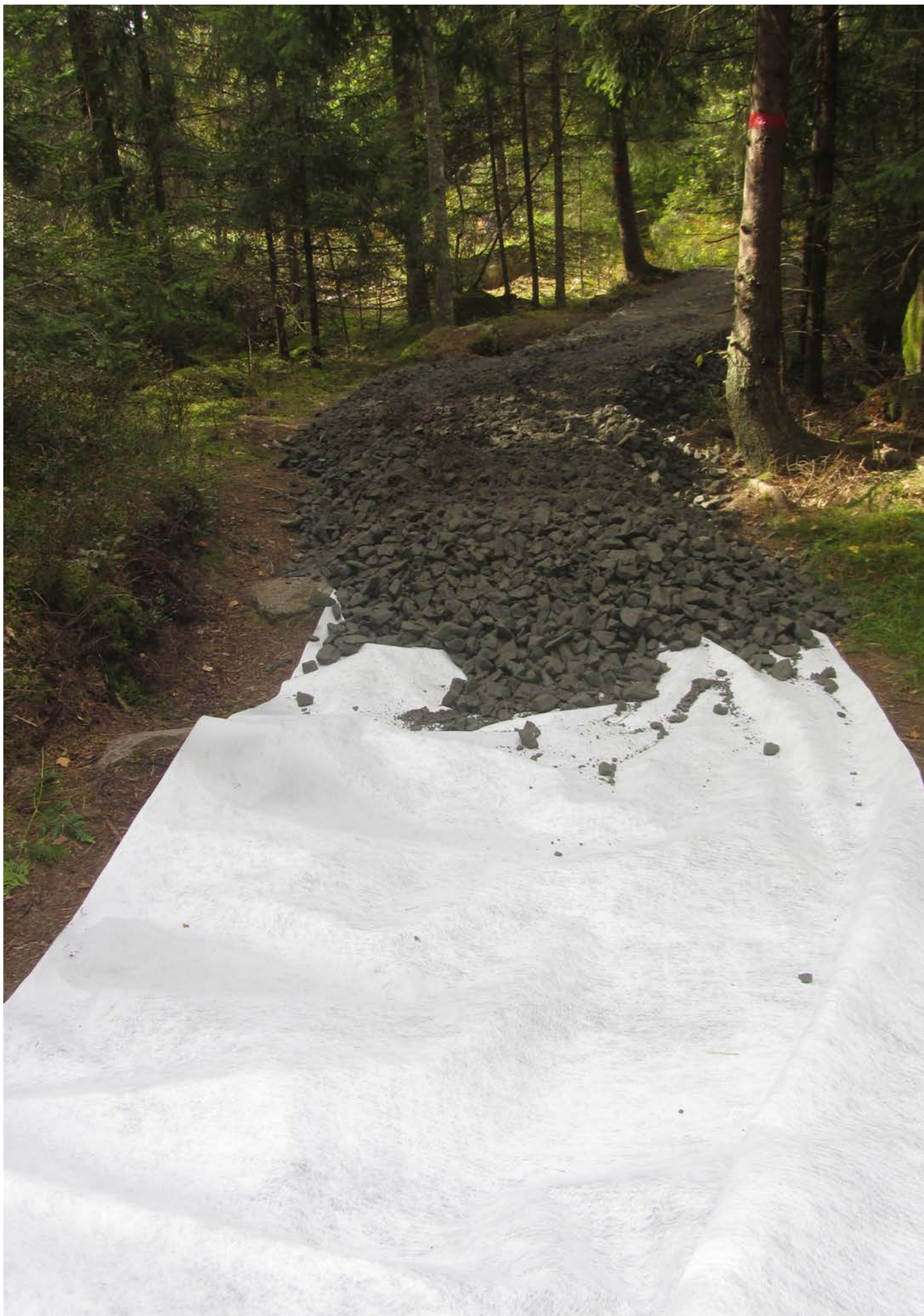
Bild från anläggande av väg i Vedyxaskogen. 7 september 2021.
