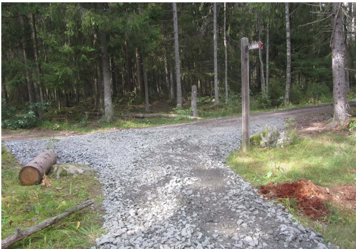
Bild från anläggande av väg i Vedyxaskogen. 7 september 2021.
